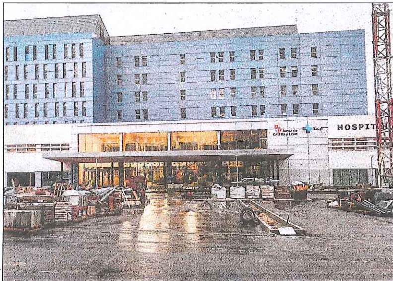
Estado de las obras en el Hospital Santa Bárbara de Soria, ayer. M.H.
